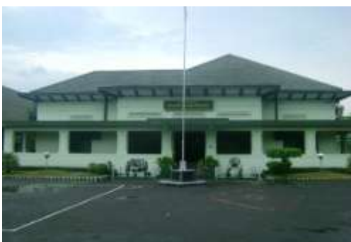
Gambar Gedung Kodam
