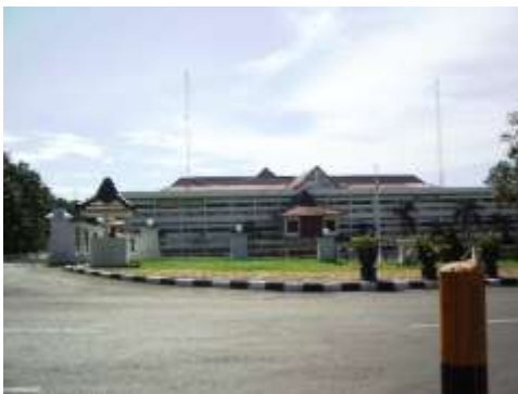
Gambar Gedung Polda
