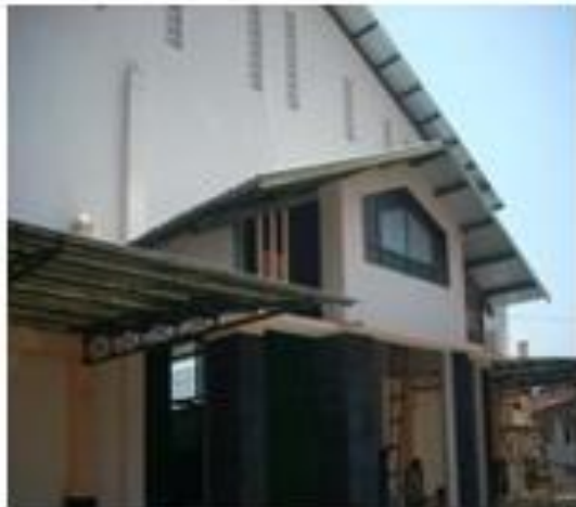
Gedung Serba Guna tampak luar
