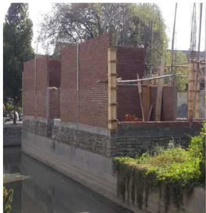
Masjid yang sedang dibangun
