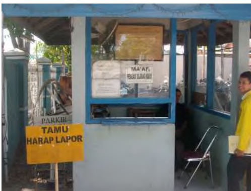
Gambar 6.3 Kondisi Pos Keamanan
