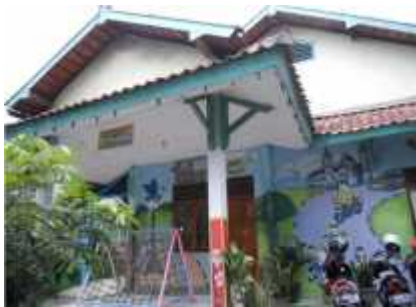
Gedung TK Usaha
