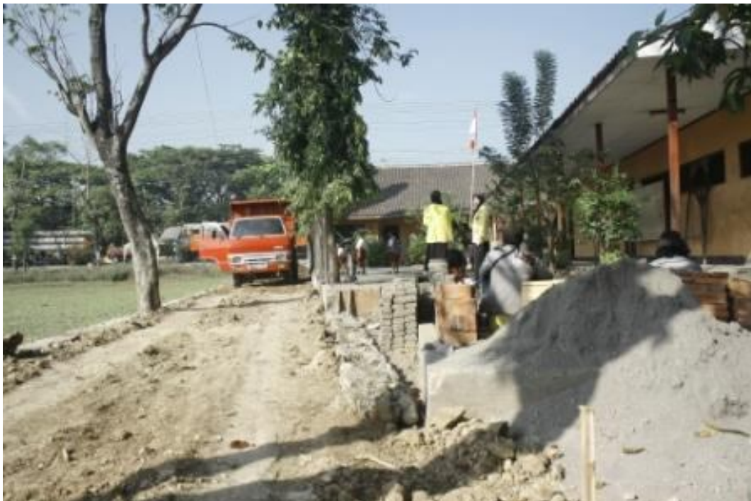
Gambar 10. Pembangunan di SDN Mangkangkulon 01
