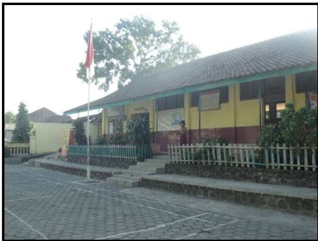
Foto Ruangan Kelas SDN Beringin 02 Tampak dari Depan
