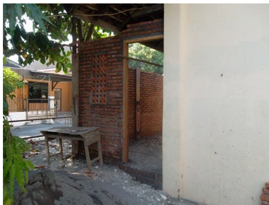
Ruang dapur dan ruang pramuka yang sedang dibangun
