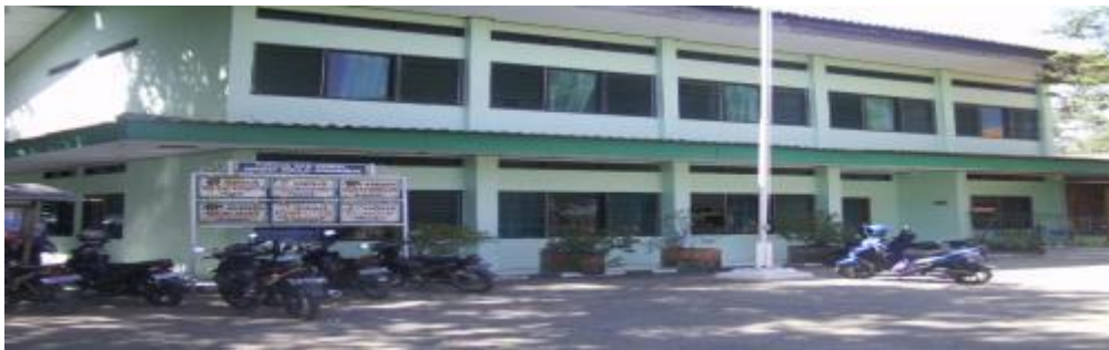
Gedung Kantor SKB Kendal
